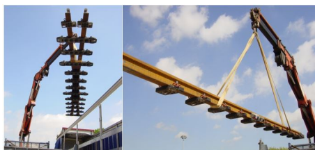
Figure 2.115: A la izquierda descarga de cruzamiento premontado con placas ADH. A la derecha descarga de contraaguja premontada con junta aislante y placas ADH.
