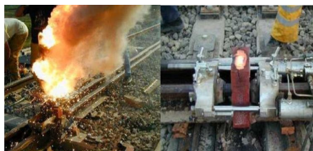
Figure 2.111: Soldadura de las juntas del desvío a la vía general. Liberación de tensiones.
