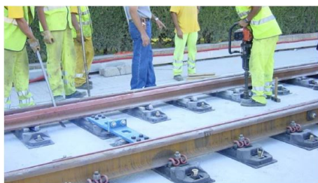
Figure 2.120: Apretado de la sujeción una vez endurecida la resina de fijación del inserto
