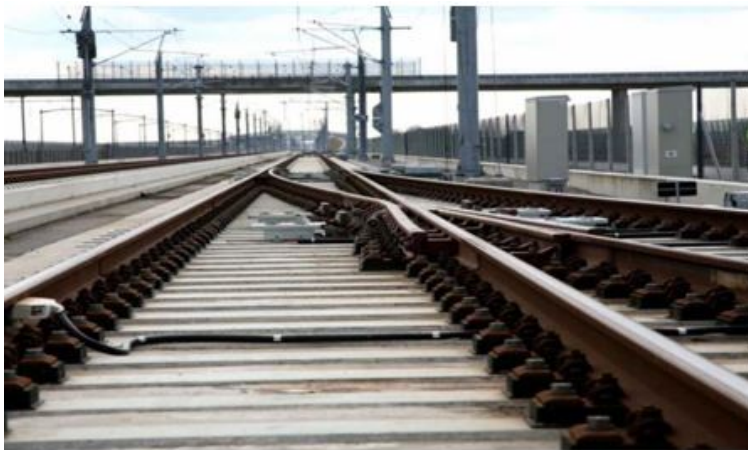
Figure 2.127: Vista general del sistema Rheda 2000 para desvíos
