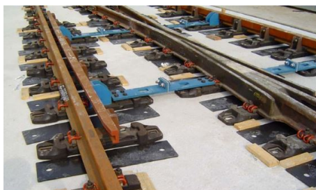
Figure 2.117: Aparato de vía preparado sobre la solera de hormigón, antes del taladrado de los orificios para las fijaciones.
