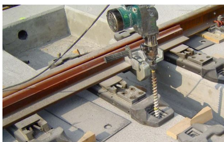
Figure 2.118: Operación de taladrado de los orificios para las fijaciones
