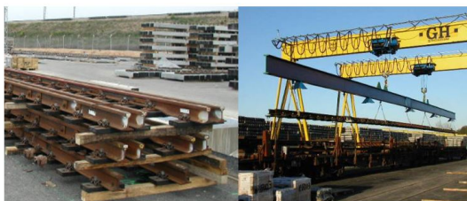
Figure 2.78: Descarga y acopio de los elementos que componen el desvío en la base de montaje
