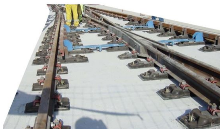
Figure 2.114: Vista general de desvío montado sobre vía en placa
