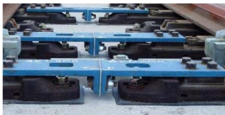
Figure 2.122: Corrección de defectos de nivelación mediante el empleo de calas de regulación.
