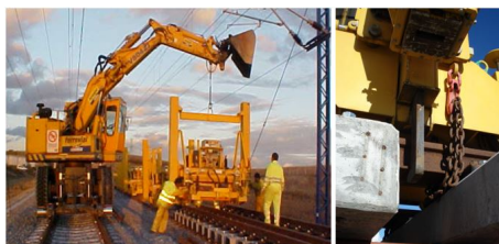
Figure 2.95: Posicionado de los pórticos PEM sobre los desvíos premontados y anclaje de los mismos
