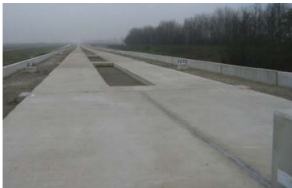
Figure 2.135: Vista general del hormigonado de la base de hormigón en la zona de desvío
