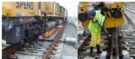
Figure 2.113: Soldadura de las juntas del desvío a la vía general. Liberación de tensiones.
