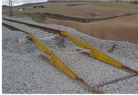
Figure 2.91: Conexión de la rampa de acceso a la vía provisional en la zona del desvío
