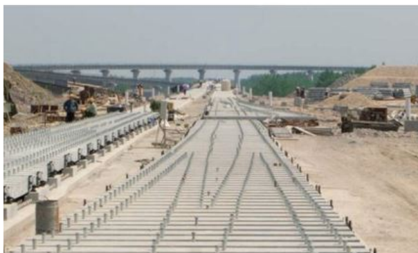
Figure 2.150: Vista general de las placas prefabricadas una vez finalizada su colocación y previamente al hormigonado de la base hidráulica.
