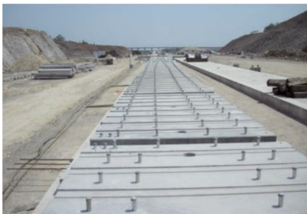
Figure 2.151: Vista general de las placas prefabricadas colocadas en obra. Aparecen visibles los orificios para las sujeciones y los huecos y juntas para los accionamientos y demás elementos específicos del desvío
