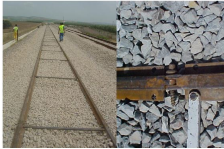
Figure 2.92: Extendido de vía provisional en la zona del desvío. Detalle de los elementos de unión que configuran la vía provisional
