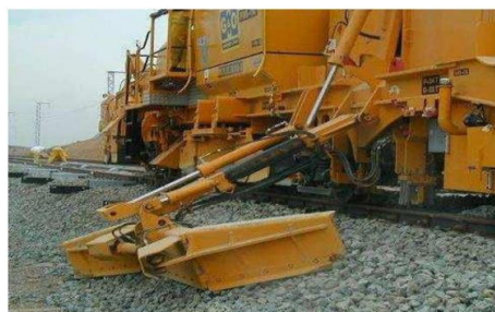
Figure 2.109: Operaciones de perfilado de la banqueta de balasto
