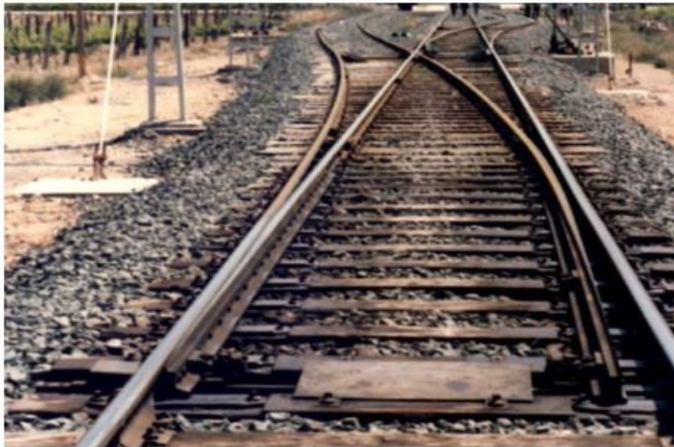
Figure 2.10: Vista general de desvío tipo A FUENTE: Catálogo de Desvíos Ferroviarios de la empresa JEZ [3]
