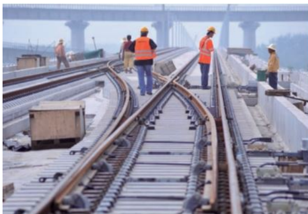
Figure 2.154: Vista general de aparato de vía, una vez colocados todos sus elementos y dispositivos de seguridad y accionamiento.
