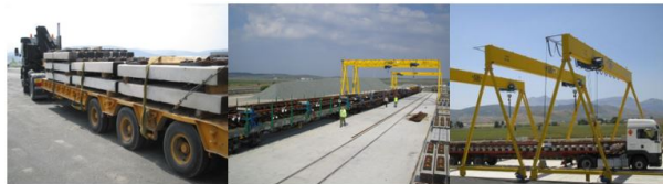
Figure 2.87: Recepción de suministro de materiales en la base de montaje de vía
