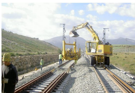
Figure 2.105: Retirada de los PEM mediante una viga de carga y retroexcavadora
