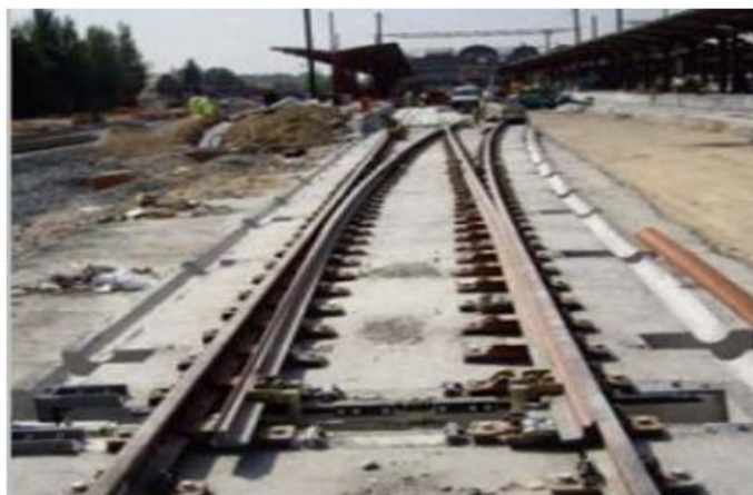
Figure 2.15: Vista general de desvío tipo P FUENTE: Catálogo de Desvíos Ferroviarios de la empresa JEZ [3]
