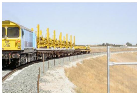
Figure 2.93: Transporte del desvío premontado desde la base de montaje de vía hasta su lugar de puesta en obra mediante el empleo de plataformas.
