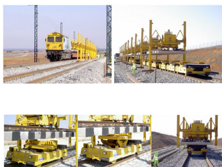
Figure 2.97: Proceso de descarga de los pórticos PEM con el desvío premontado sobre los carros elevadores LEM
