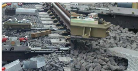
Figure 2.112: Soldadura de las juntas del desvío a la vía general. Liberación de tensiones.
