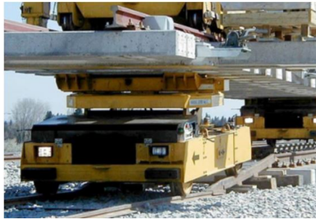
Figure 2.98: Acceso de los carros con el desvío a la vía auxiliar a través de la rampa
