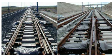
Figure 2.106: Protección de los componentes del desvío previa al riego de balasto.
