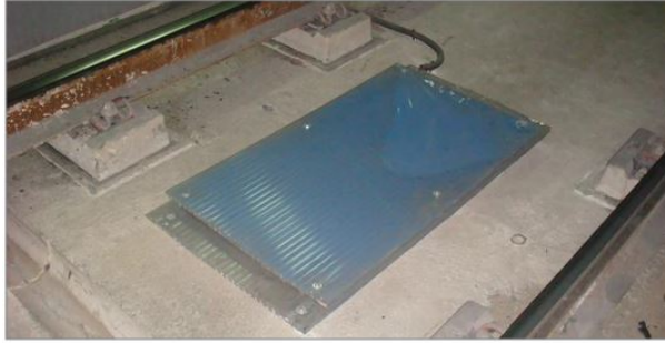
Figure 2.158: Sistema de instalación de Eurobaliza en vía en placa
