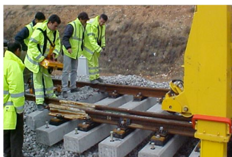
Figure 2.103: Ajuste de la posición definitiva del aparato mediante los movimientos longitudinales de los pórticos y conexión con la vía general
