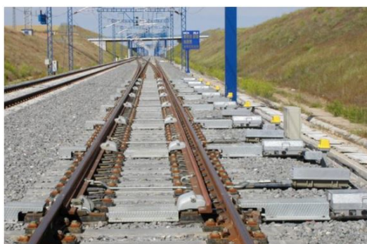
Figure 2.19: Desvío tipo AV FUENTE: Catálogo de Desvíos Ferroviarios de la empresa JEZ [3]
