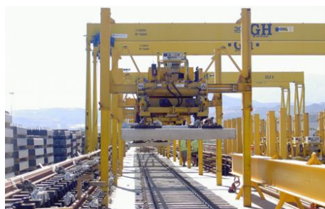
Figure 2.96: Procedimiento de carga de los pórticos PEM y los desvíos premontados
