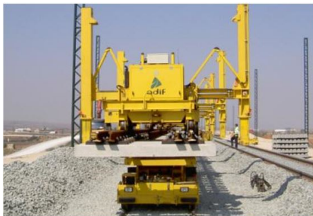
Figure 2.99: Avance del conjunto PEM/LEM a través de la vía auxiliar hasta la ubicación definitiva del desvío
