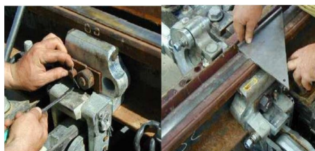
Figure 2.110: Montaje de dispositivos de encerrojamiento
