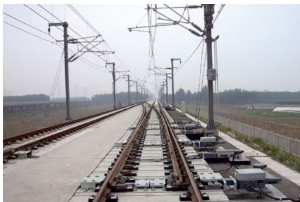
Figure 2.145: Vista general de aparatos de vía en placa tipo FF Bögl, en la línea de alta velocidad Beijing-Tianjin (China)
