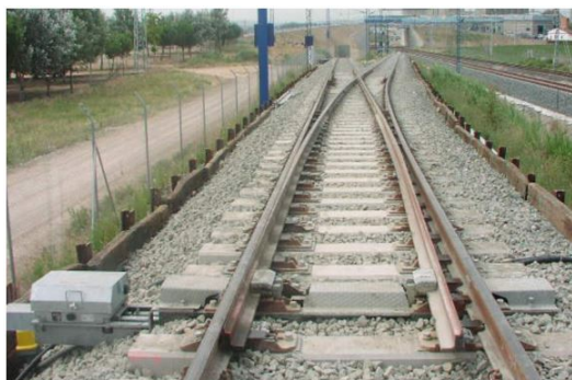
Figure 2.17: Vista general de desvío tipo G FUENTE: Catálogo de Desvíos Ferroviarios de la empresa JEZ [3]
