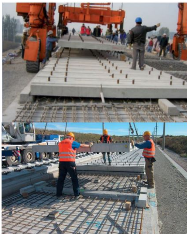
Figure 2.149: Disposición de las placas prefabricadas en su ubicación definitiva mediante equipos auxiliares especiales
