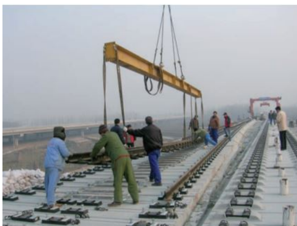
Figure 2.153: Descarga y fijación de los carriles del desvío tras la colocación de las sujeciones
