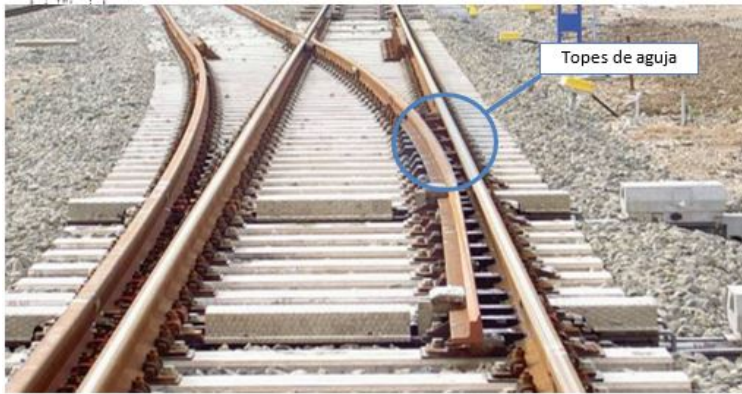
Figure 2.34: Vista general de la ubicación de los topes de aguja en un desvío
