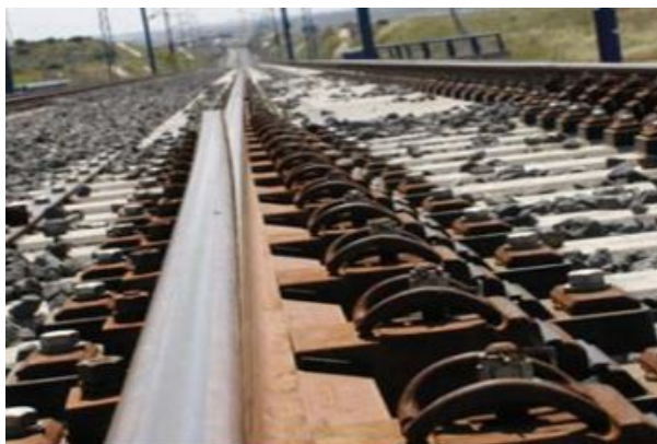
Figure 3.78: Vista general de la zona de contacto entre la aguja, que se mantiene fija, y la contraaguja, que desliza sobre ella.
