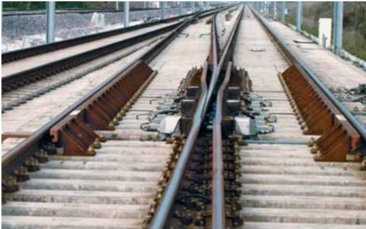
Figure 2.42: Desvío con corazón de punta móvil
