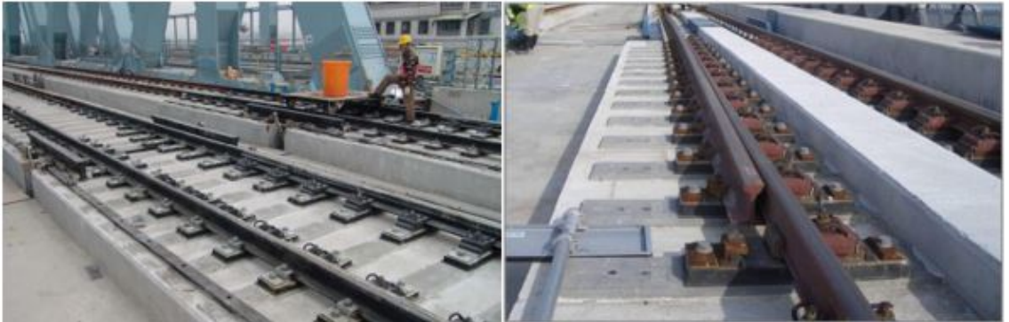
Figure 3.75: Vista general de aparato de dilatación montado sobre vía en placa
