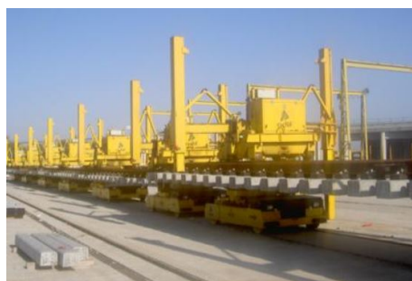
Figure 2.94: Transporte del desvío premontado desde la base de montaje de vía hasta su lugar de puesta en obra mediante el empleo de carros LEM.
