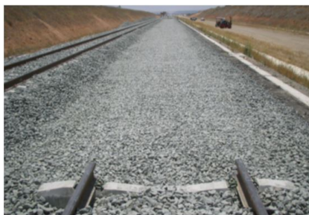
Figure 2.89: Rebaje y compactación de la zona donde se dispondrá el desvío
