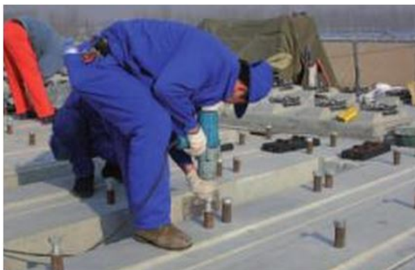
Figure 2.152: Fijación de los elementos de sujeción del carril sobre la vía en placa
