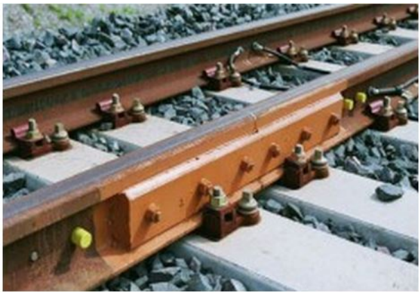
Figure 2.61: Vista general de junta aislante encolada FUENTE: Catálogo Juntas aislantes MT y ETW 1 (Elektro-Thermit GMBH & Co. KG) [20]
