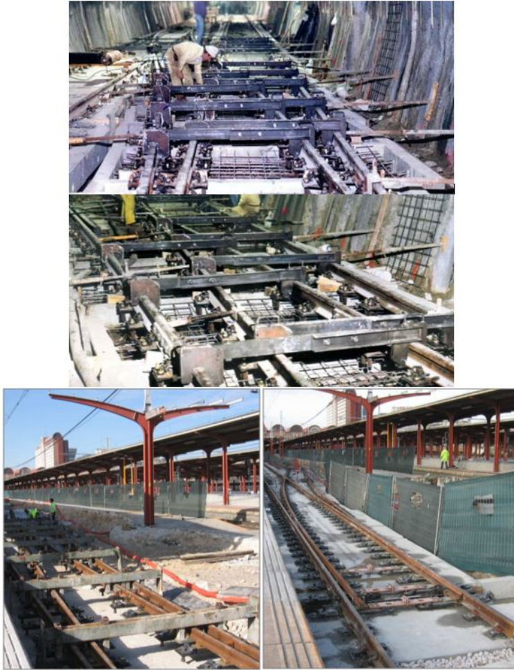
Figure 2.126: Vista general de puesta en obra de desvío mediante el sistema up&down FUENTE: Aparatos de vía con placas adherizadas tipo (R/A) ADH (Railtech) [33]
