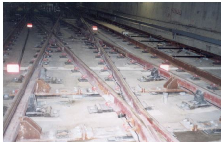
Figure 2.125: Vista general de aparato de vía con placas adherizadas ADH una vez hormigonado FUENTE: Aparatos de vía con placas adherizadas tipo (R/A) ADH (Railtech) [33]
