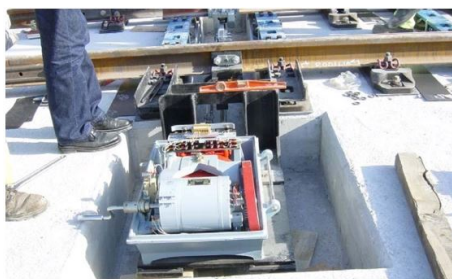
Figure 2.116: Huecos previstos en la solera de hormigón para la instalación del motor y la timonería del aparato
