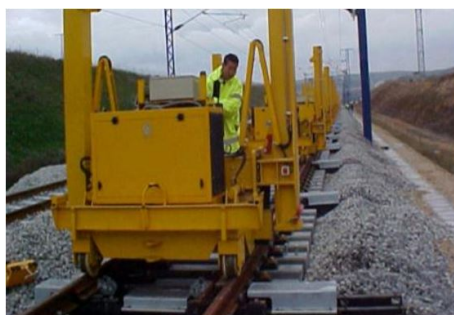
Figure 2.104: Retirada de los pórticos de la zona del desvío una vez embridado este.
