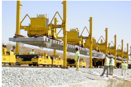
Figure 2.100: Izado del desvío mediante los pórticos en su ubicación aproximada y retirada de los carros
