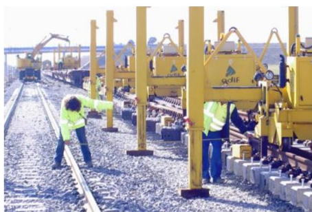
Figure 2.102: Ajuste de la posición definitiva del aparato mediante los movimientos transversales de los pórticos
