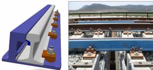
Figura 2.19: Elementos de soporte del carril en el hueco de la junta de estructura en aparatos de dilatación,(FUENTE: ADIF crossing switches and expansion devices for high speed track [22])
