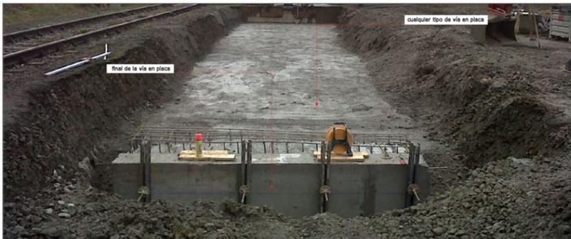
Figura 3.49: Ejecución de murete de apoyo para el módulo en el extremo de la sección de vía en placa,(FUENTE: Información facilitada por la empresa Rhomberg Rail)
