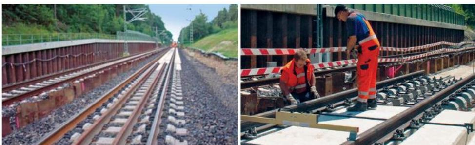
Figura 3.43: Vista general de la zona de transición ejecutada en el tramo Cologne-Aachen-Federal border con el sistema de vía en placa NBU,(FUENTE: NBU System Concept, Execution and Construction Site Report [22])
