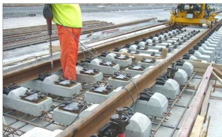
Figura 3.35: Vista general de zona de transición a la salida de túnel. Armado de la vía en el último tramo de vía en placa
