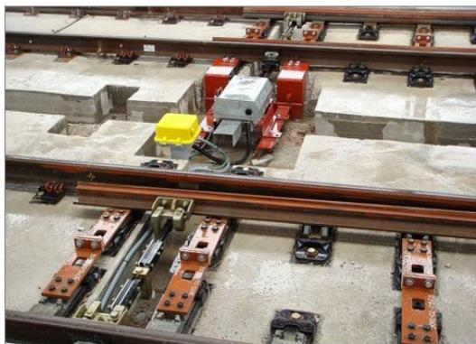
Figura 2.29: Reserva de espacio para el motor y la timonería de un desvío en vía en placa
