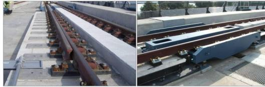
Figura 2.21: Vista general de aparato de dilatación montado sobre vía en placa
