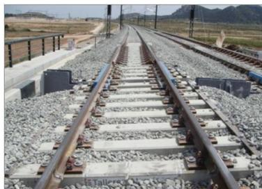
Figura 2.20: Vista general de aparato de dilatación montado en vía sobre balasto
