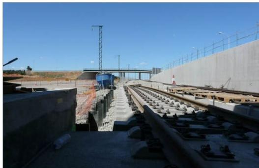
Figura 4.12: Ejecución de muretes guardabalasto
