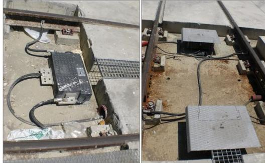
Figura 2.32: Figura 32. Unidades de sintonía TI-21 de Bombardier instaladas en vía estuchada
