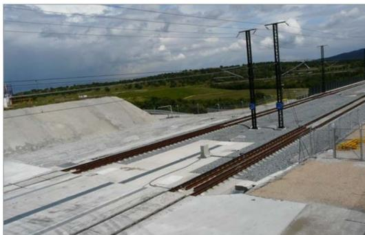
Figura 3.32: Vista general de la transición placa-balasto ejecutada en los túneles de Guadarrama (Boca Norte)
