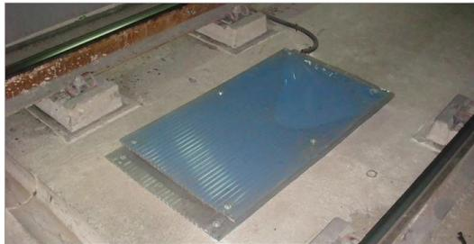
Figura 2.31: Sistema de instalación de Eurobaliza en vía en placa
