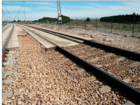
Figura 3.40: Vista general de la transición vía en placa (Edilon) a vía sobre balasto ejecutada en el tramo de ensayos de Oropesa
