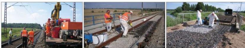
Figura 3.22: Procedimientos de encolado del balasto (A la izquierda, mediante trenes equipados con equipos de inyección, en el centro, mediante equipos de inyección móviles, a la derecha, vertido manual),(FUENTE: Track stability using ballast bonding method (Stjepan Lakusic) [14])
