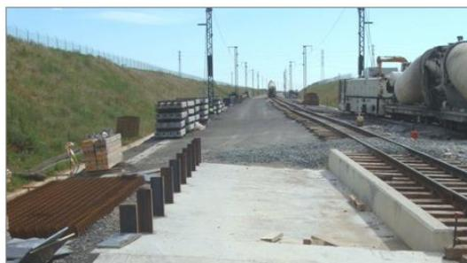
Figura 3.16: Losa de hormigón en zona de transición placa-balasto a la salida de los túneles de Guadarrama,(FUENTE: Montaje de vía de alta velocidad en placa (iIR España) [11])
