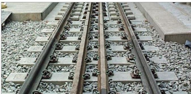
Figura 3.44: Vista general de la transición de vía en placa (sistema LVT) a vía sobre balasto
