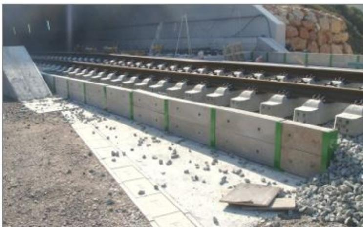
Figura 3.28: Vista general de muretes guardabalasto desmontables en zonas de transición,(FUENTE: Montaje de vía de alta velocidad en placa (iiR España) [11])
