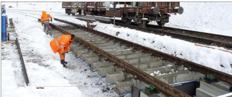
Figura 3.53: Colocación y fijación de los carriles a las traviesas,(FUENTE: Información facilitada por la empresa Rhomberg Rail)
