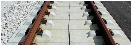
Figura 2.34: Cable radiante LZB longitudinal anclado a la vía en placa
