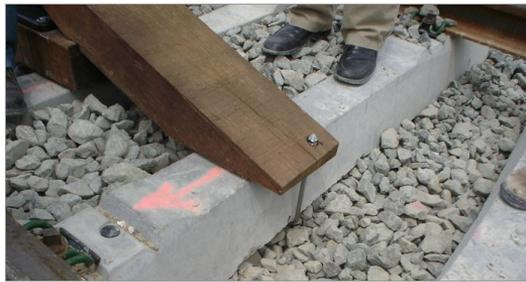
Figura 2.30: Sistema habitual de anclaje de baliza ASFA a traviesa
