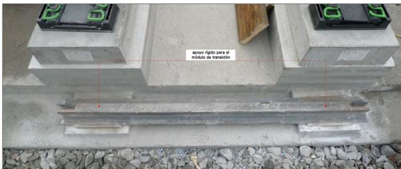
Figura 3.50: Vista en detalle de la zona de apoyo del módulo,(FUENTE: Información facilitada por la empresa Rhomberg Rail)
