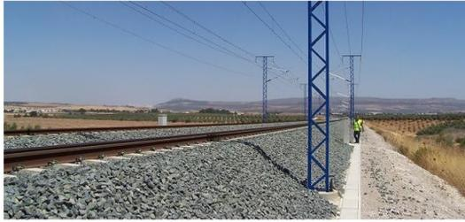
Figura 2.33: Canaleta prefabricada de hormigón en sección de vía sobre balasto
