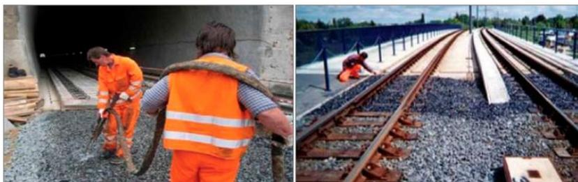
Figura 3.23: Encolado de balasto en zonas de transición. (A la izquierda a la salida de un túnel, a la derecha en el estribo de un viaducto),(FUENTE: Track stability using ballast bonding method (Stjepan Lakusic) [14])
