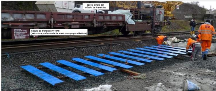
Figura 3.51: Posicionamiento del módulo V-TRAS,(FUENTE: Información facilitada por la empresa Rhomberg Rail)
