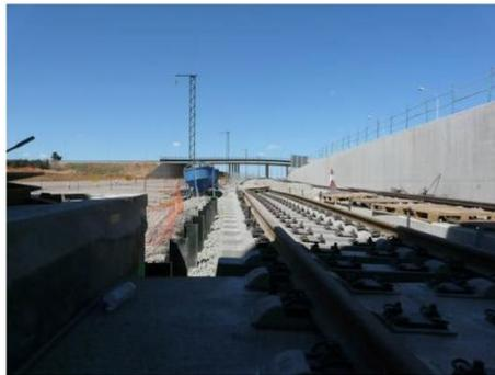
Figura 3.33: Vista general de zona de transición a la salida de túnel. Perfiles para murete guardabalasto y sujeciones para carriles adicionales
