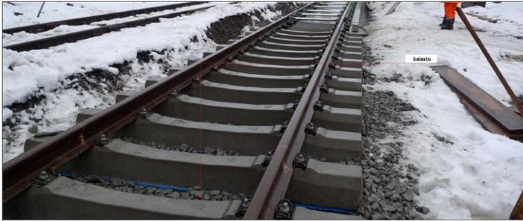
Figura 3.54: Disposición del balasto a en la sección,(FUENTE: Información facilitada por la empresa Rhomberg Rail)
